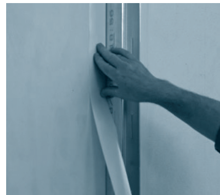
3. In alternativa Knauf Trennfix può essere applicato sulla muratura, accanto al profilo metallico, prima della posa delle lastre.
