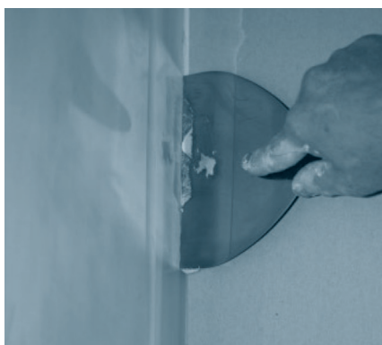
5. Stuccare dopo l'applicazione delle lastre
