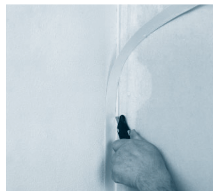
6. Dopo l'essiccazione dello stucco tagliare la parte sporgente del nastro
