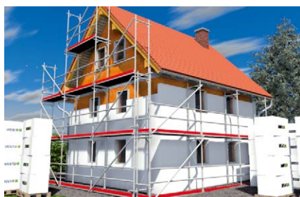
Incollaggio di pannelli isolanti per sistemi ETICS
