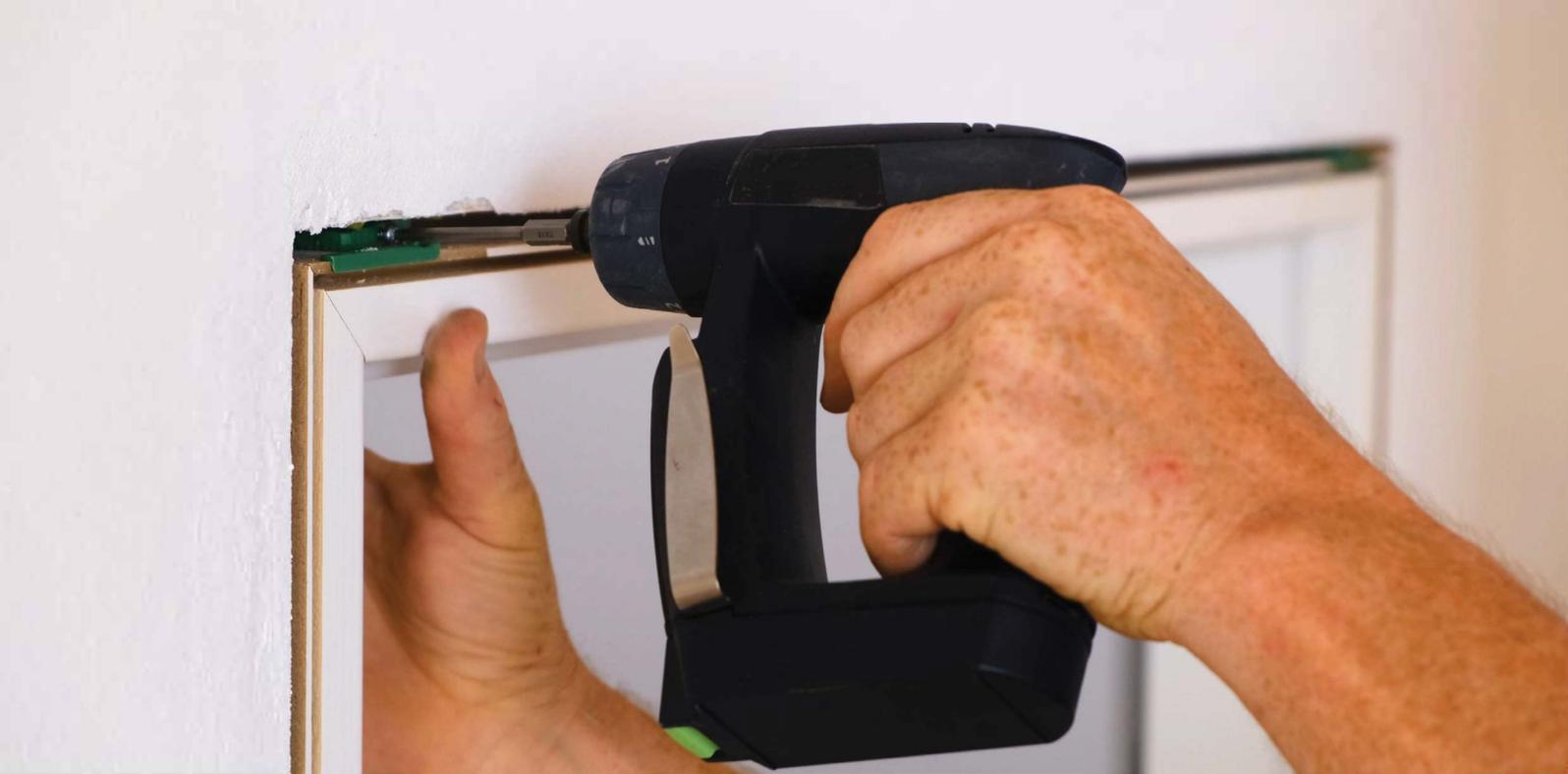
2 **BLOCCO MECCANICO DEL TELAIO**
