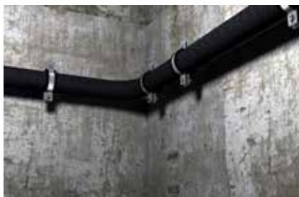
Fissaggio delle condotte in plastica
